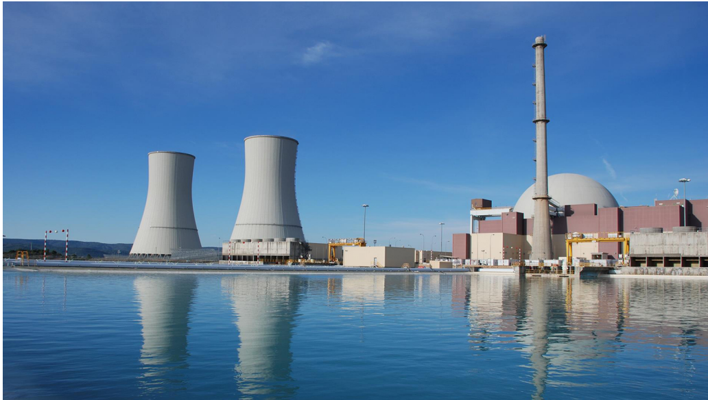
La central nuclear de Trillo.
