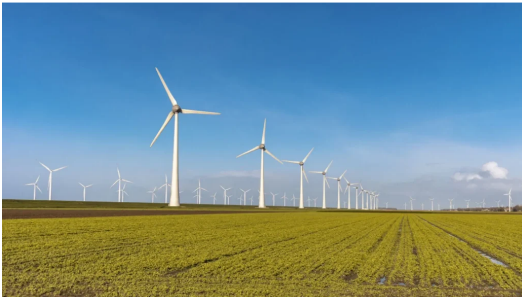
Parque eólico Golden Plains, Australia.
