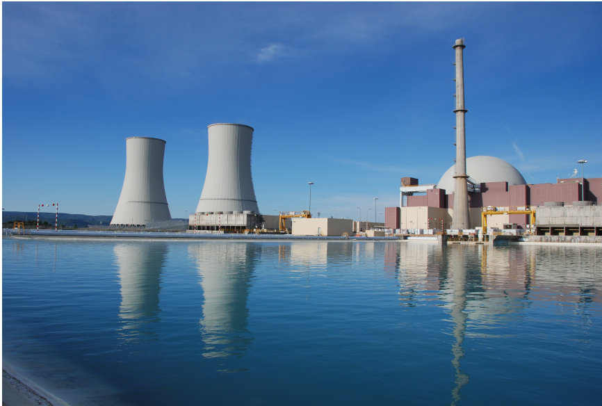
Endesa apuesta por la prórroga nuclear para "seguir aportando firmeza y reduciendo costes"
