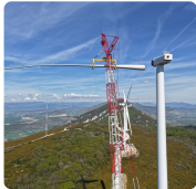
GES - Global Energy Services prevé aumentar este año su volumen de negocio en instalación más del 20%
