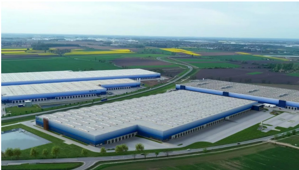
Sungrow abre en Polonia su primera fábrica de inversores solares en Europa.
