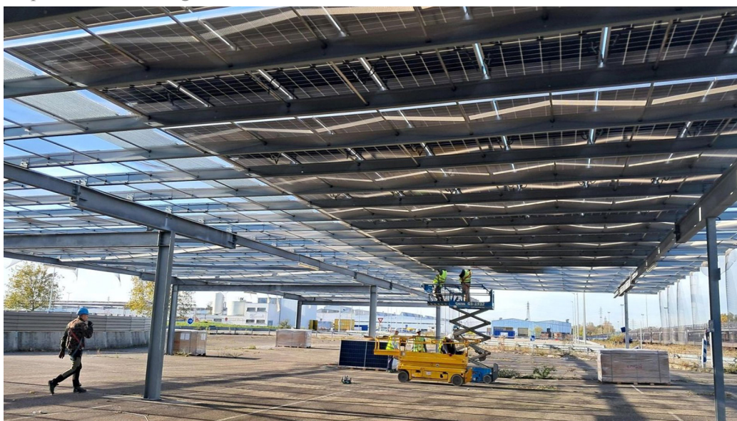
Prosolia Energy despliega marquesinas fotovoltaicas híbridas en plantas de Stellantis en Francia.
