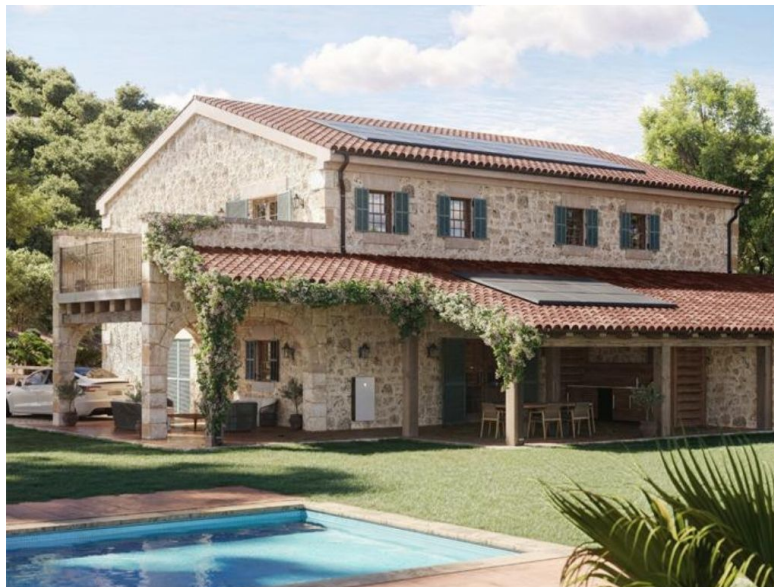
Autoconsumo híbrido: la integración solar y eólica como eje del suministro energético del futuro.
