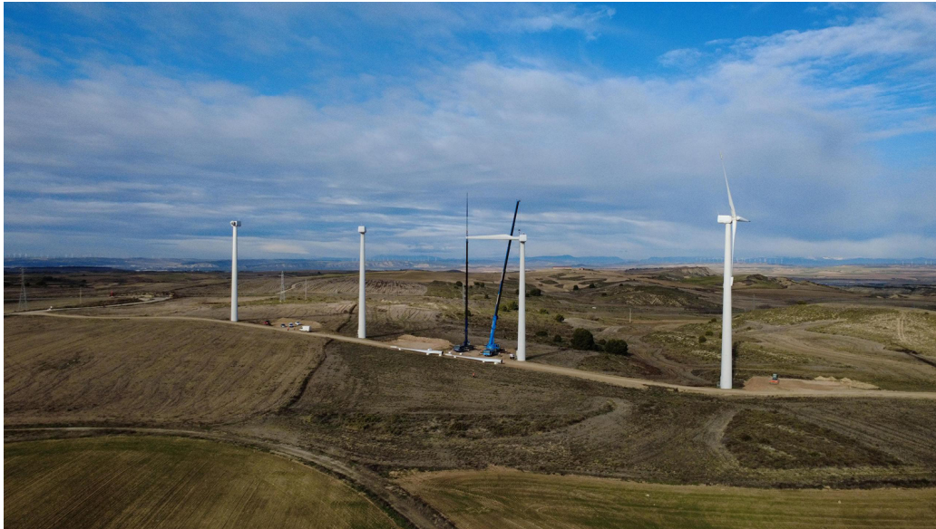
RenerCycle se adjudica el desmantelamiento y reciclaje de tres parques eólicos de Grupo Enhol en Navarra.
