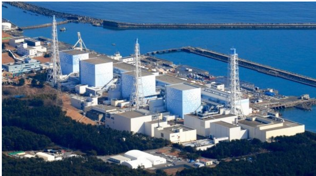
La central Kashiwazaki-Kariwa, la mayor planta del mundo, ubicada en Niigata (noroeste).
