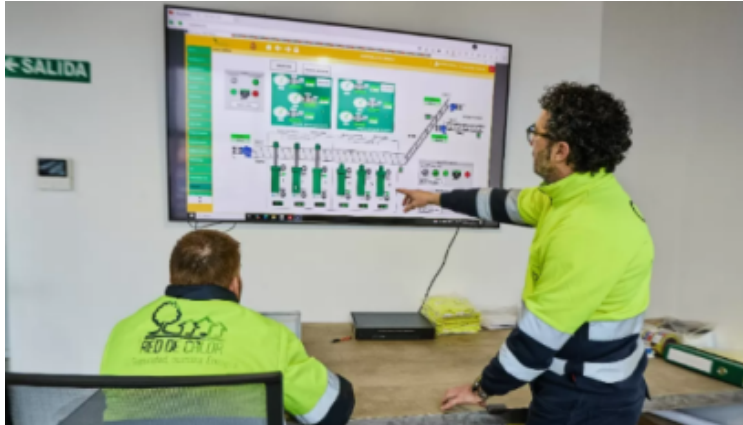
La Red de Calor de Soria cumple diez años en funcionamiento con más de 160 edificios conectados
