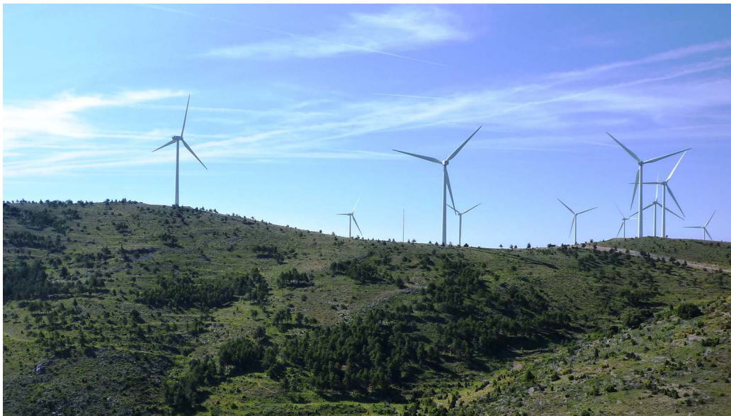
Parque eólico de Enel Green Power España.
