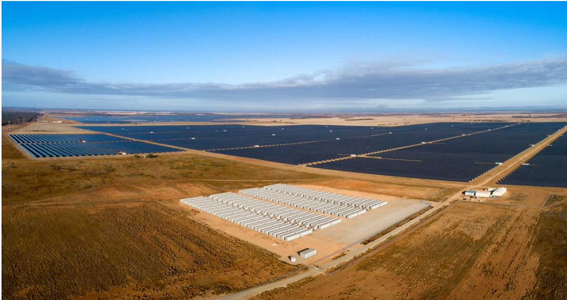
La batería Limondale de ocho horas, junto a la planta solar adyacente.
