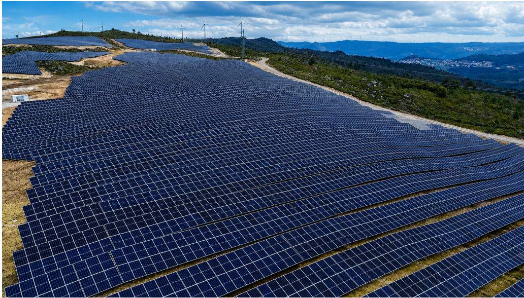
GameChange Energy convierte la ejecución bancable en fidelidad del cliente con cinco proyectos fotovoltaicos de gran escala para Zagope en Portugal.
