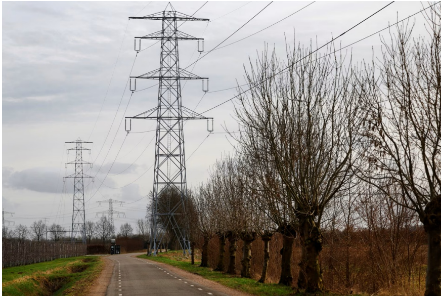
TenneT alerta de crecientes riesgos para la seguridad eléctrica de Países Bajos y pide implantar un mecanismo de capacidad
