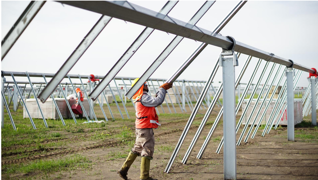
Soltec instala un planta de 220 megavatios en México que creará 200 puestos de trabajo.
