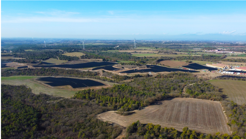
La planta fotovoltaica Carbeso Solar de Ignis.
