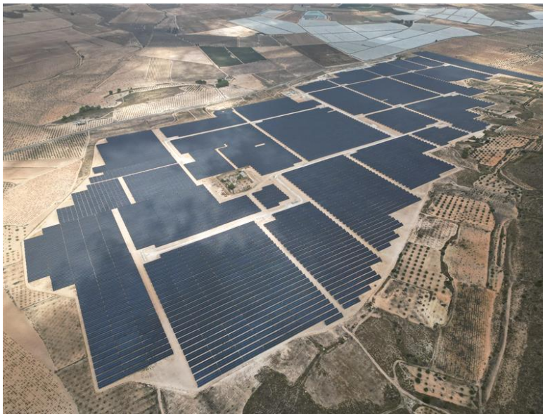
Endesa pone en marcha su mayor planta solar en Murcia con 145 MW de potencia
