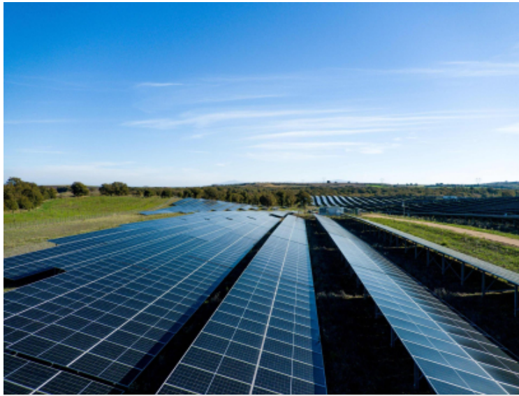
Iberdrola alcanza los 5 millones de MWh vendidos en Italia
