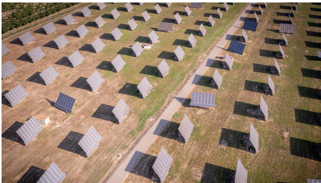
Una instal·lació fotovoltaica a Lleida
