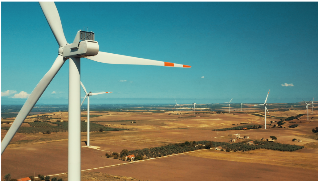
Parque eólico de Iberdrola en Italia.
