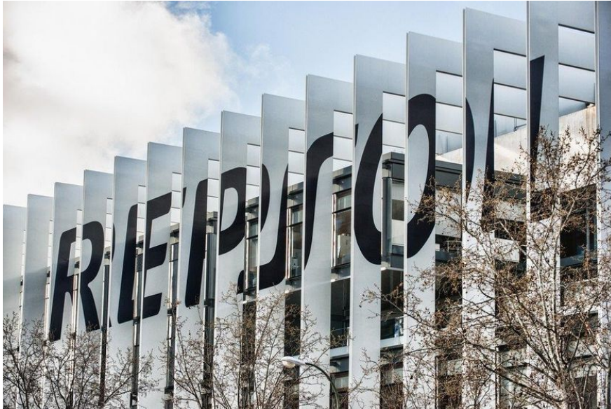
Repsol reclamará 125 millones por los daños sufridos en el apagón
