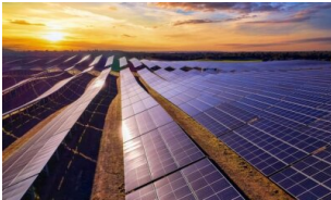
El sector fotovoltaico reclama una mejor
