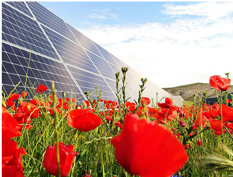
Instalaciones solares de Solaria.
