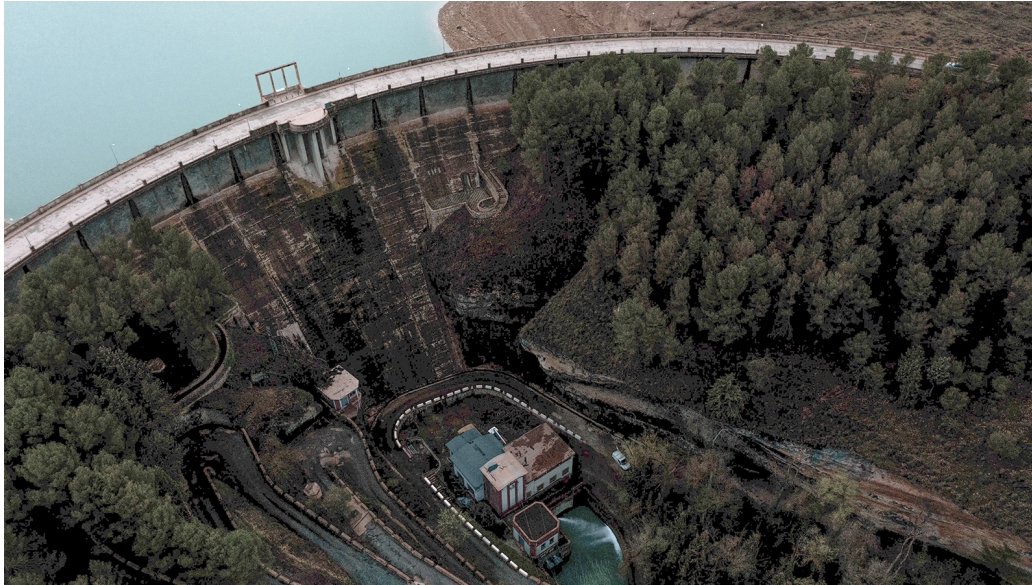
La Central Hidroeléctrica de Bermejales.
