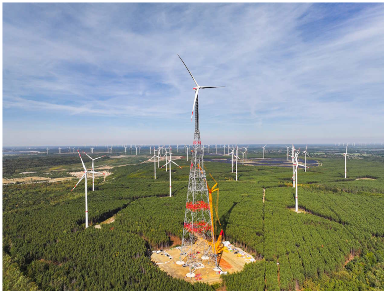
Gicon instala el aerogenerador más alto del mundo gracias a su torre de celosía con extensión telescópica
