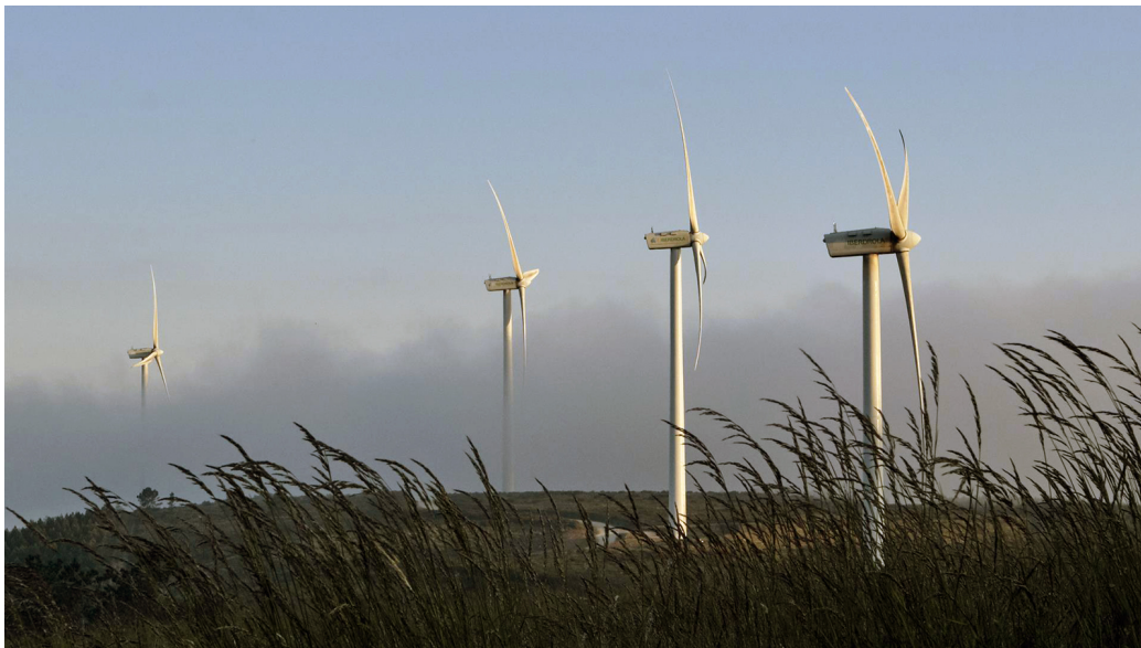
Aerogeneradores en el parque eólico de Sil y Meda, a 31 de mayo de 2023, en Esgos, Ourense, Galicia (España).
