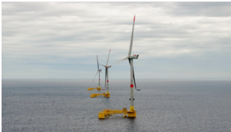
El primer parque eólico flotante de Ocean Winds en Francia ya inyecta energía a la red
