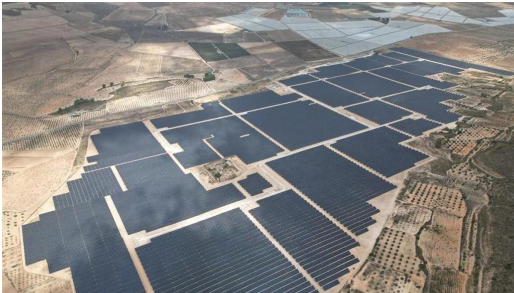
Vista aérea de la planta solar de Balbona, en Jumilla (Murcia)
