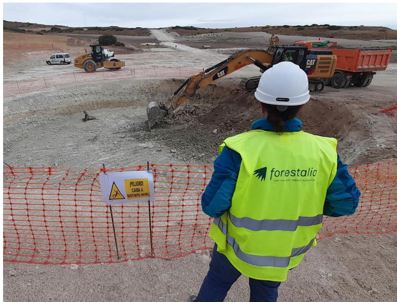
Obras del nuevo parque eólico de Forestalia en Campo de Belchite.
