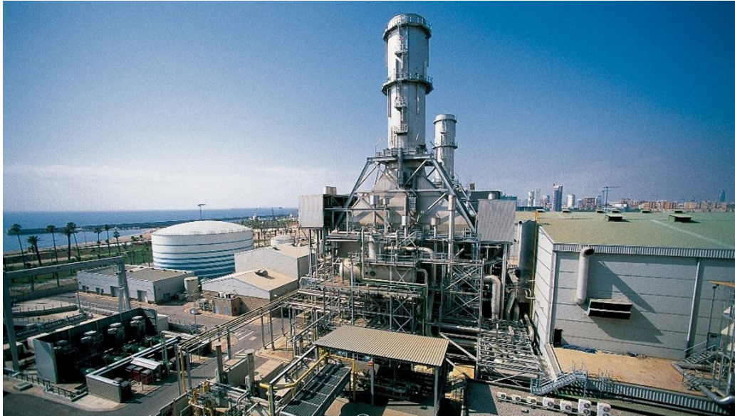
Central térmica de ciclo combinado.
