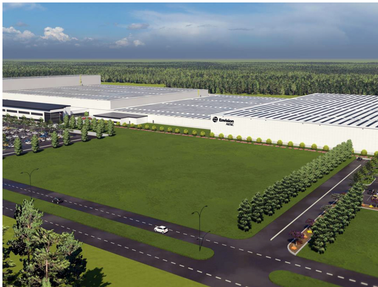
Gigafactoría de baterías. FOTO: Grupo Envision
