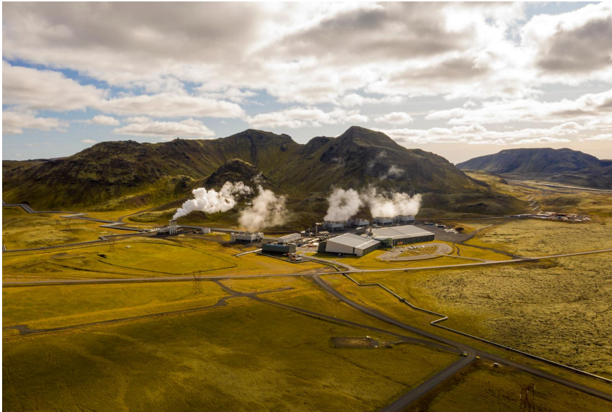
Vista aérea de la central geotérmica de Hellisheidi en Islandia, destacando la infraestructura industrial y las columnas de vapor.
