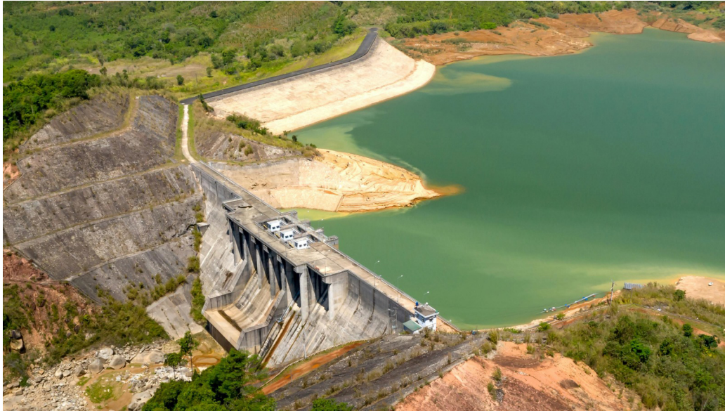
El Gobierno adjudica 165 millones en ayudas al almacenamiento mediante bombeo reversible.
