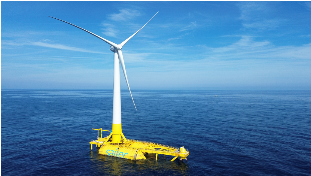
El aerogenerador marino flotante DemoSATH.
