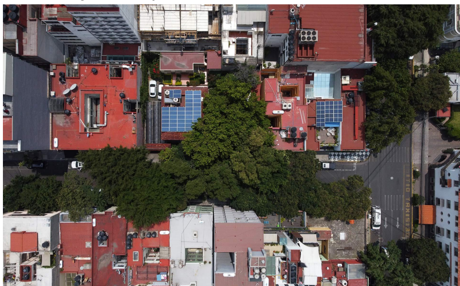
Paneles solares instalados en un entorno moderno
