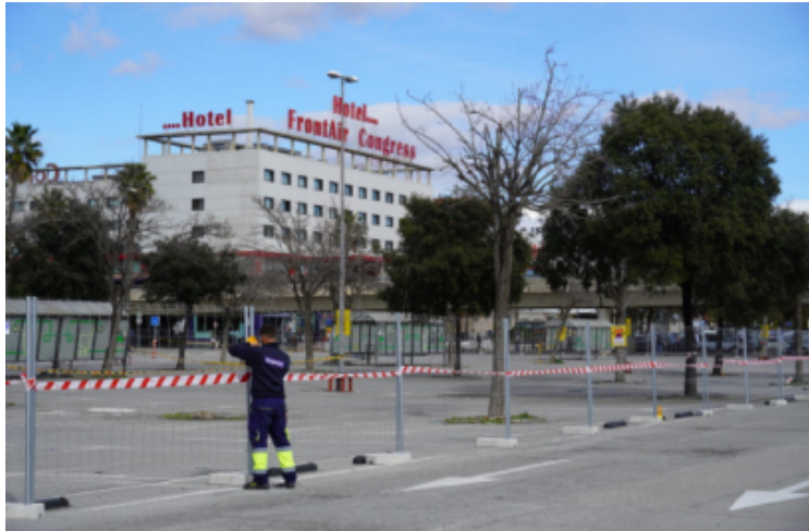
El Área Metropolitana de Barcelona inicia la instalación de una pérgola fotovoltaica de 3,25 MW en Sant Boi de Llobregat
