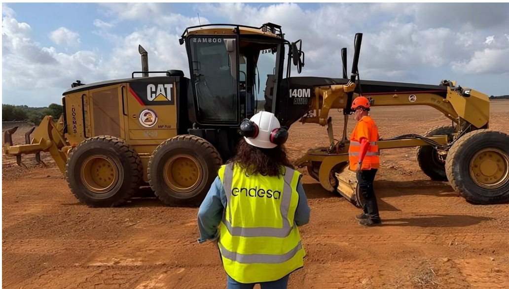
Endesa inicia la construcción de su mayor parque solar en Baleares.
