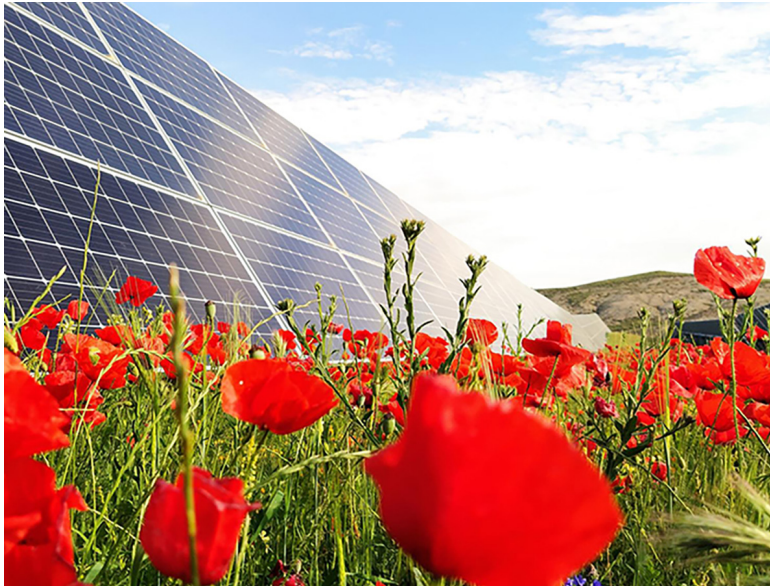
Instalaciones solares de Solaria.
