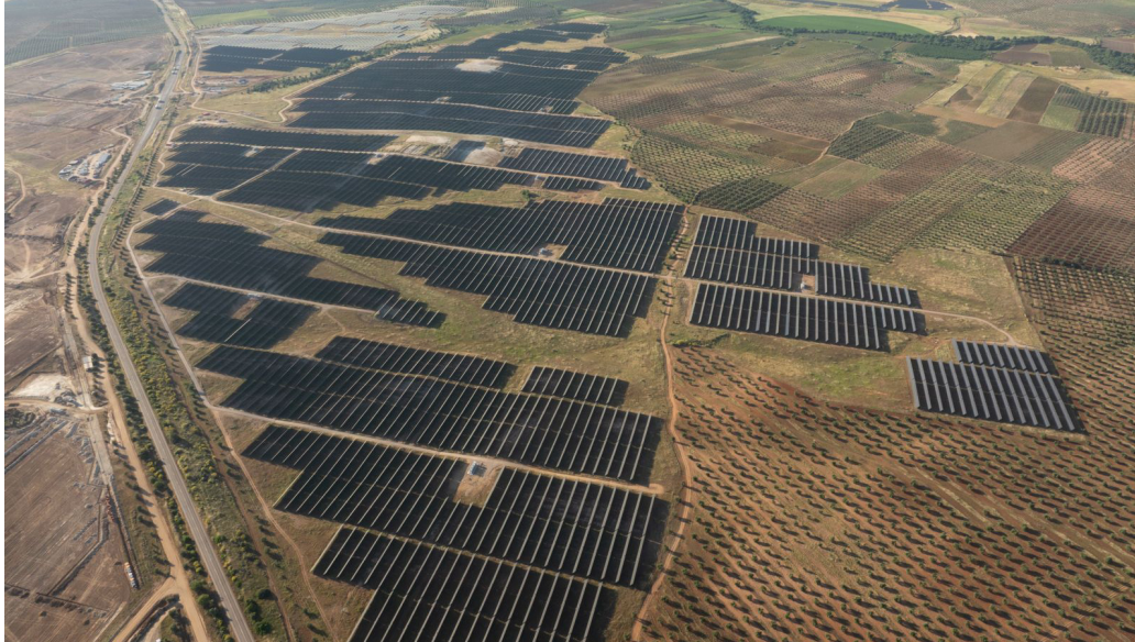
Renopool, el mayor proyecto fotovoltaico de Plenitude.
