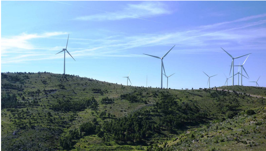
Parque eólico de Enel Green Power España.
