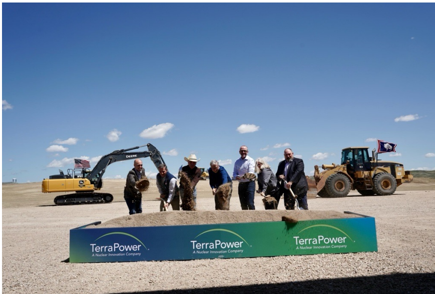
Inicio de las obras del nuevo reactor modular de TerraPower.
