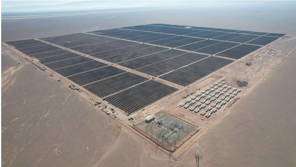
Proyecto Aurora, planta híbrida ubicada en Chile de energía solar y BESS (Battery Energy Storage System).
