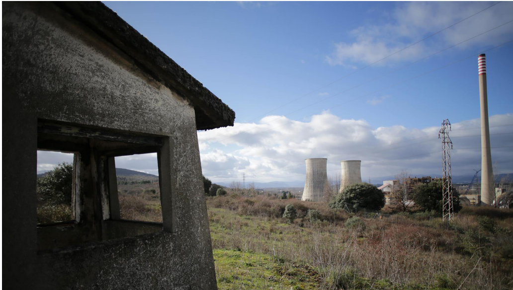
Imagen de archivo de la Central Térmica de Compostilla, en Cubillos del Sil (León).
