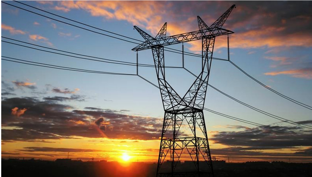
El BID otorga un préstamo de 60 millones de euros a Paraguay para ampliar su red de transmisión eléctrica.
