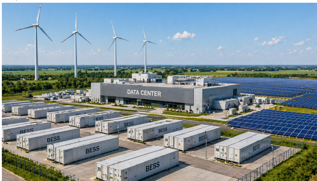
Fotovoltaica, baterías y centros de datos refuerzan la integración del sistema eléctrico
