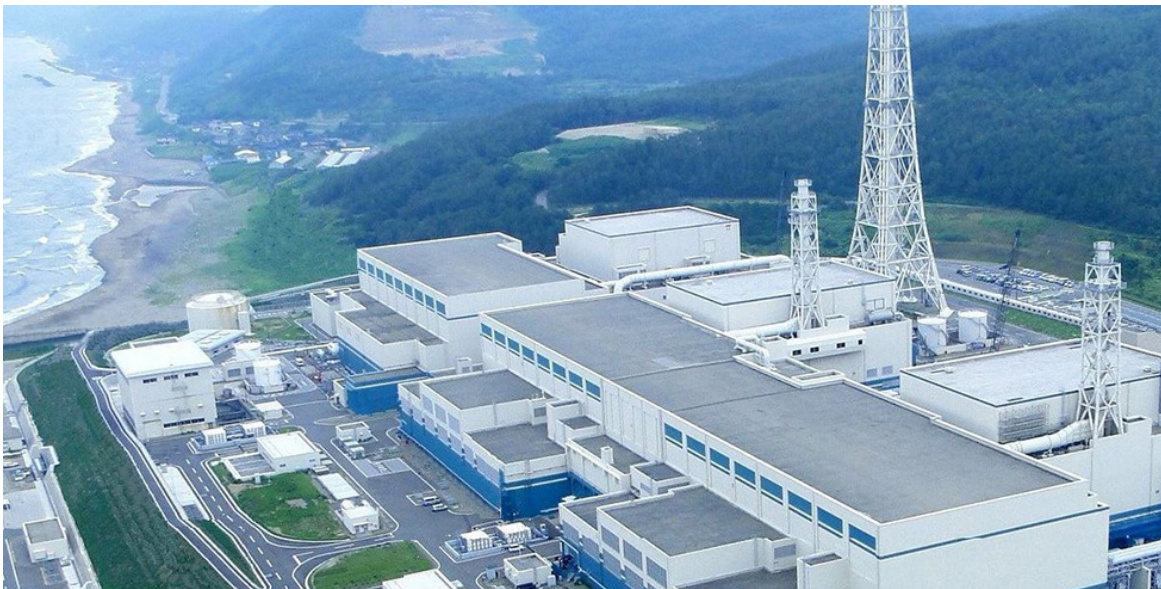
La central Kashiwazaki-Kariwa, la mayor planta del mundo, ubicada en Niigata (Japón).
