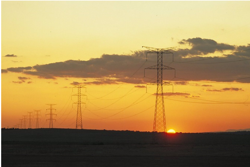
Recurso de electricidad, postes eléctricos.
