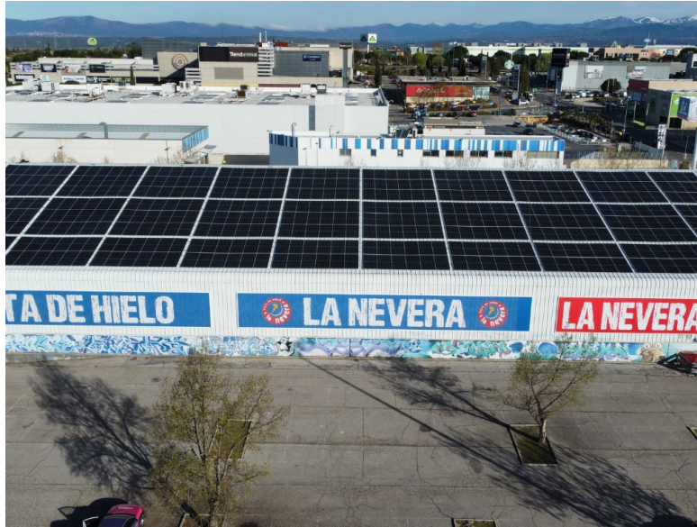
Instalación autoconsumo La Nevera, Majadahonda Madrid
