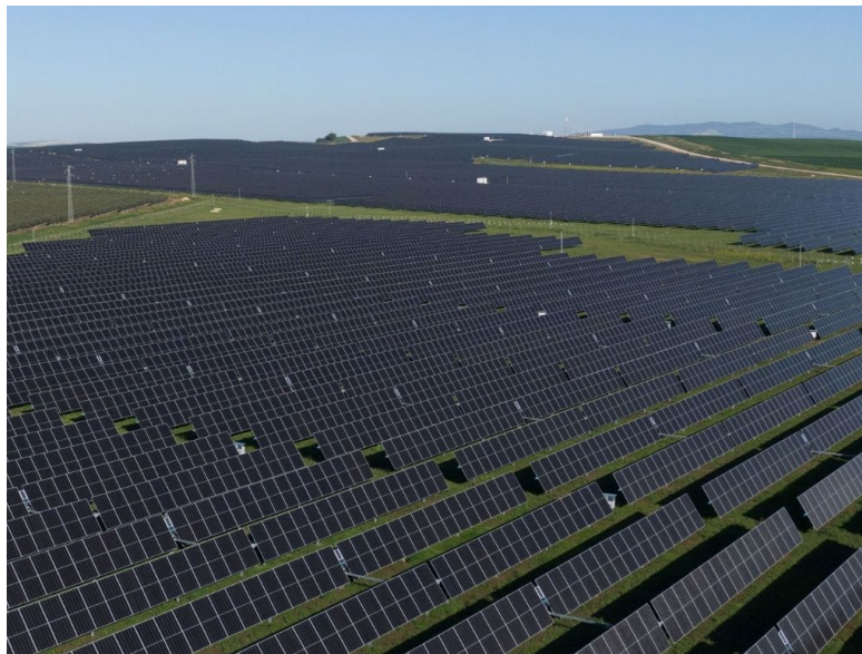
OHLA se adjudica cuatro plantas fotovoltaicas en España y supera los 3.000 MW construidos.
