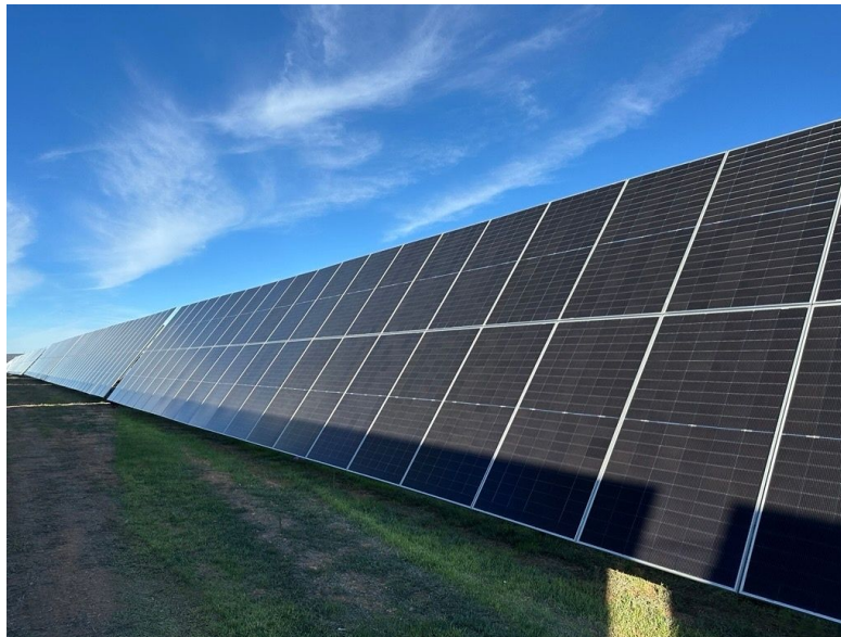
GRS construirá la planta Dintel Solar de 50 MWp en Valladolid y superará los 900 MWp en España.
